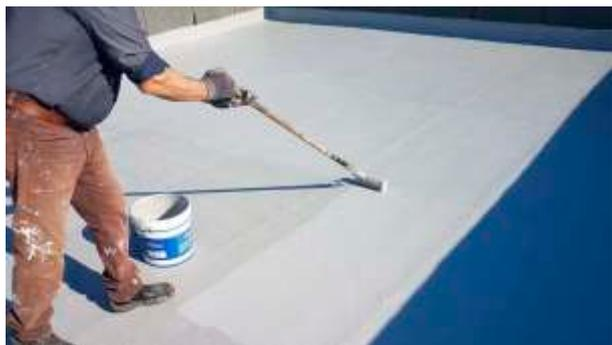
**STEP 4** - In caso sia necessario aumentare le prestazioni di calpestabilità del sistema impermeabile o di facilitare la capacità di autopulizia alla pioggia (effetto «loto») si consiglia l'applicazione di una mano di POLIUTEK VF300-T resina poliuretanica trasparente lucida.
