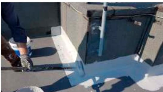
Dopo aver rivestito tutti i perimetrali e i messicani, procedere alla applicazione della prima mano di Idrostop avendo cura di distribuirlo omogeneamente ed uniformemente sulla superficie da impermeabilizzare mediante rullo per resine (lunghezza del pelo testurizzato da 6-8 mm) o penellessa su tutta la superficie da impermeabilizzare in ragione di 0,500-0,750 l/m<sup>2</sup>.
