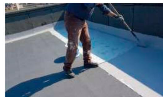
**STEP 3** - Dopo aver atteso l'asciugatura della prima mano di GUAINA PEDONABILE FIBRORINFORZATA (dopo almeno 8 ore a Temperature superiori ai 20°C) procedere alla applicazione della seconda mano di GUAINA PEDONABILE FIBRORINFORZATA avendo cura di distribuirlo omogeneamente ed uniformemente sulla superficie da impermeabilizzare mediante rullo per resine (lunghezza del pelo testurizzato da 6-8 mm) su tutta la superficie da impermeabilizzare in ragione di 0,500-0,750 l/m<sup>2</sup>.
